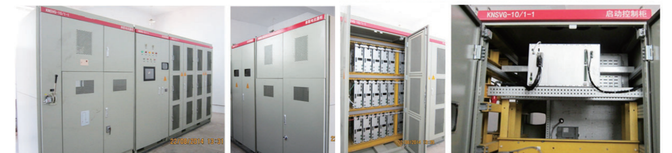
10kV/8MVA SVG of CRRC Qiqihar Co., Ltd.
